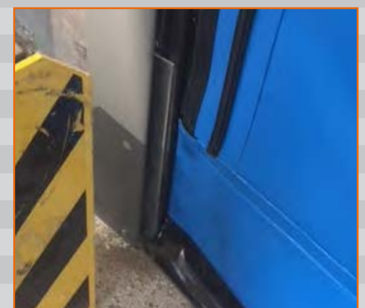
Führungsschiene mit Zip-System und Flex-Edge-Schließkante
