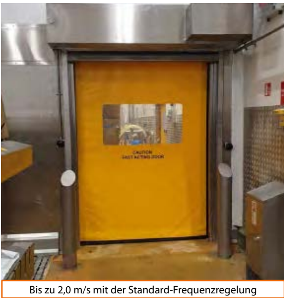
Bis zu 2,0 m/s mit der Standard-Frequenzregelung
